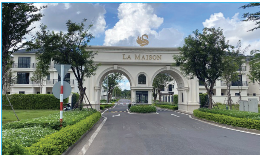
Một công trình xây dựng trên Cù lao Ông Cò.
