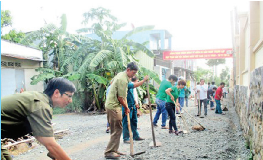
Thi công nâng cấp tuyến hẻm bên cạnh Trường Tiểu học Phước Lai.
