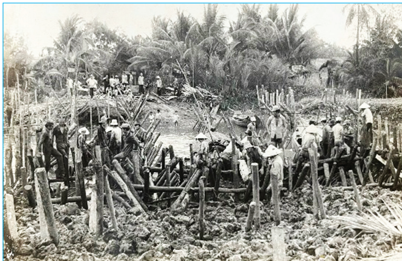
Nhân dân Phú Đông tham gia công tác thủy lợi, làm đập, ngăn mặn từ Cầu Cháy đến Giồng Ông Đông.
