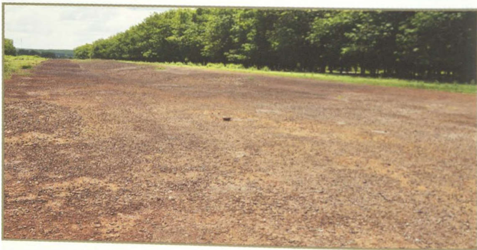
Đường băng sân bay quân sự Lộc Ninh
