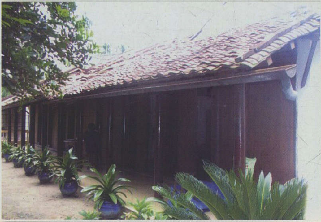
NHÀ CỔ CỦA GIA ĐÌNH ÔNG LÊ THÀNH TÔN (Xã Hiệp Phước - huyện Nhơn Trạch)
