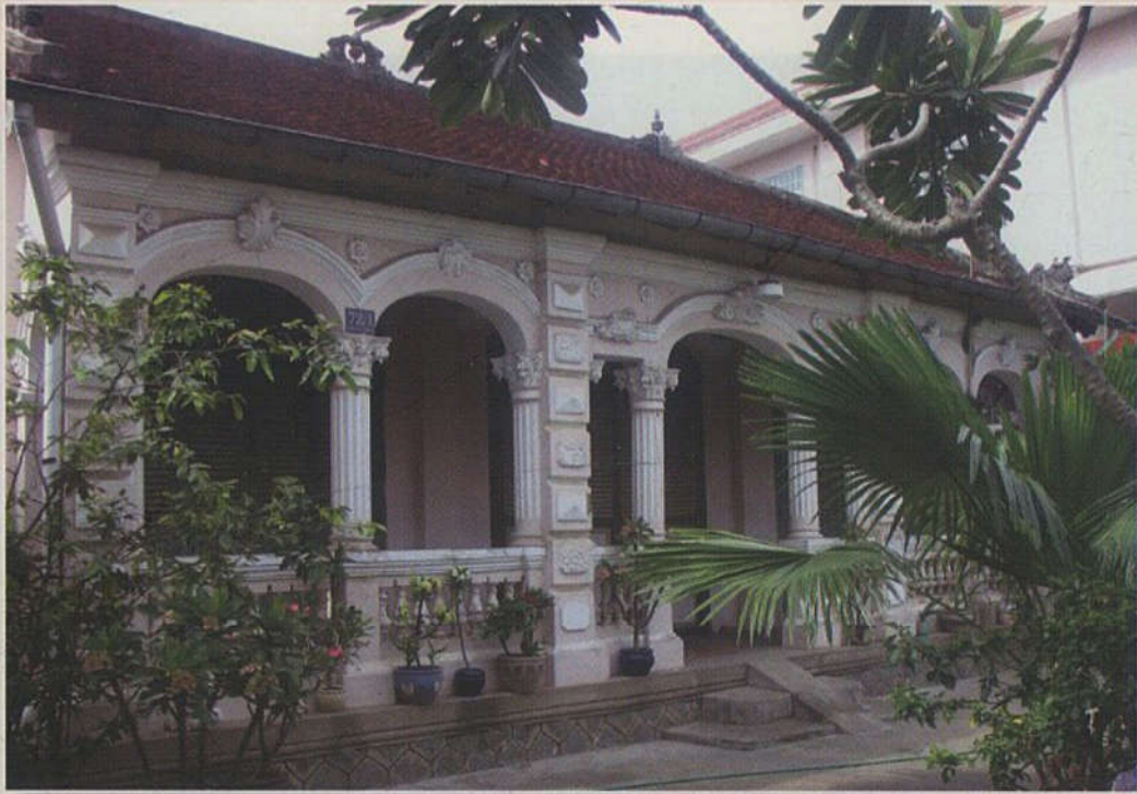
NHÀ CỔ CỦA GIA ĐÌNH ÔNG NGUYỄN BỬU KHOA (Xã Hiệp Hòa - thành phố Biên Hòa)
