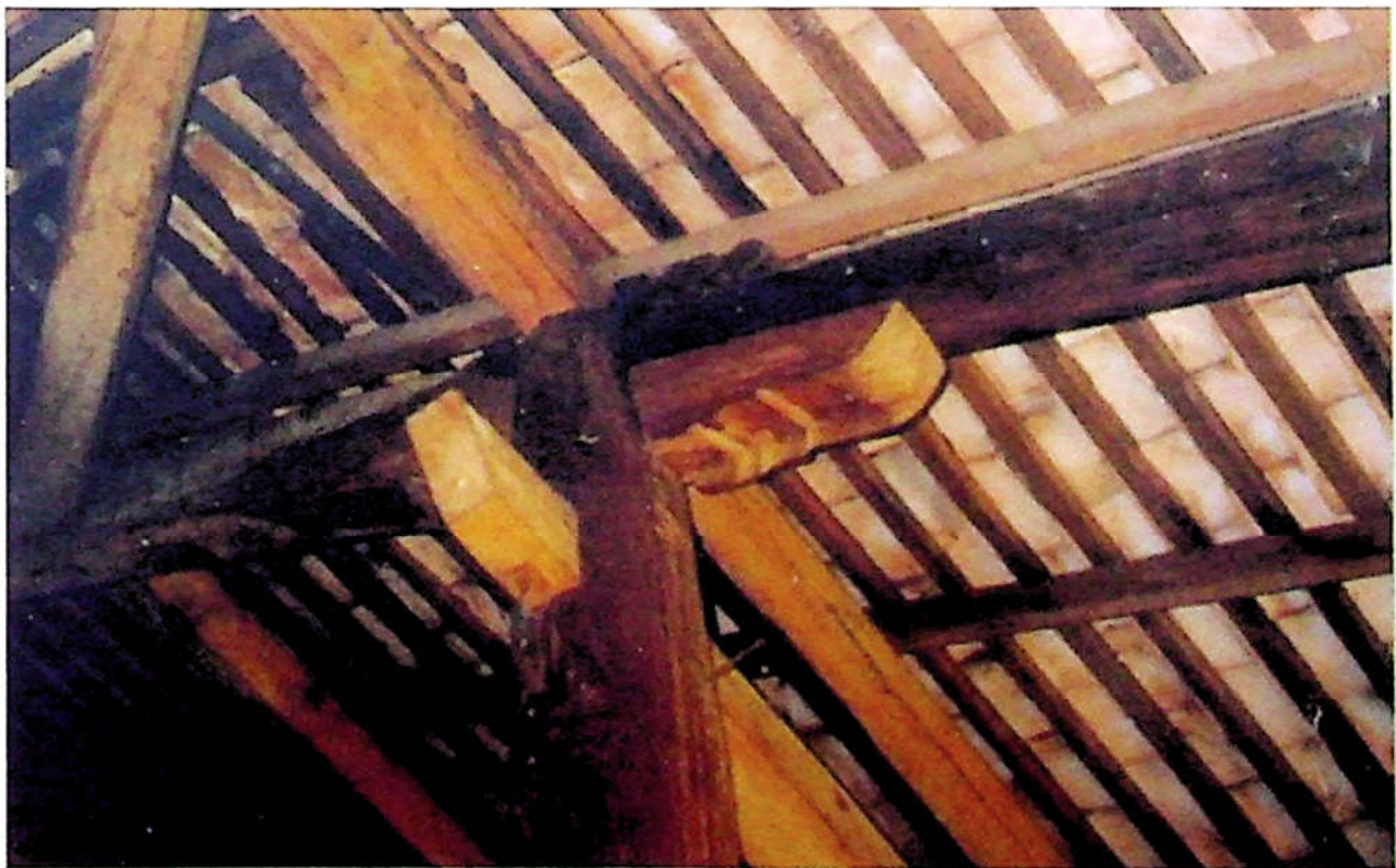
Chi tiết kèo quyết nhà cổ Nguyễn Thị Sương (xã Tam An, huyện Long Thành, tỉnh Đồng Nai)
