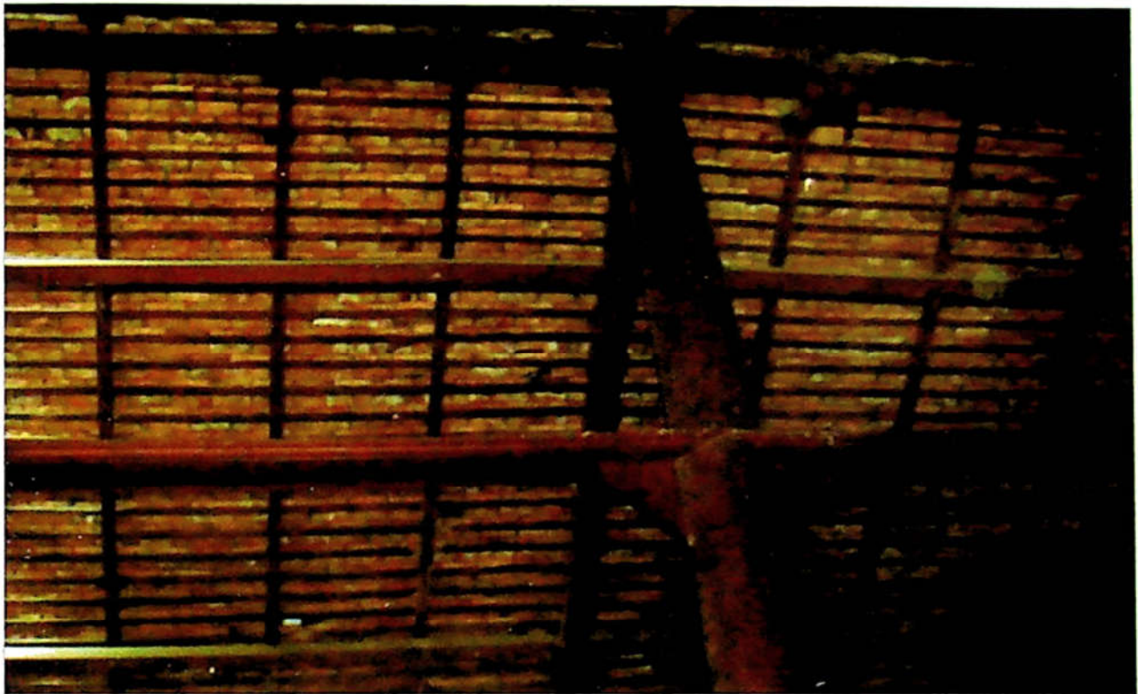
Cột chính và hệ thống rui mè nhà cổ Nguyễn Thanh Hiền (xã Phú Hội, huyện Nhơn Trạch, tỉnh Đồng Nai)
