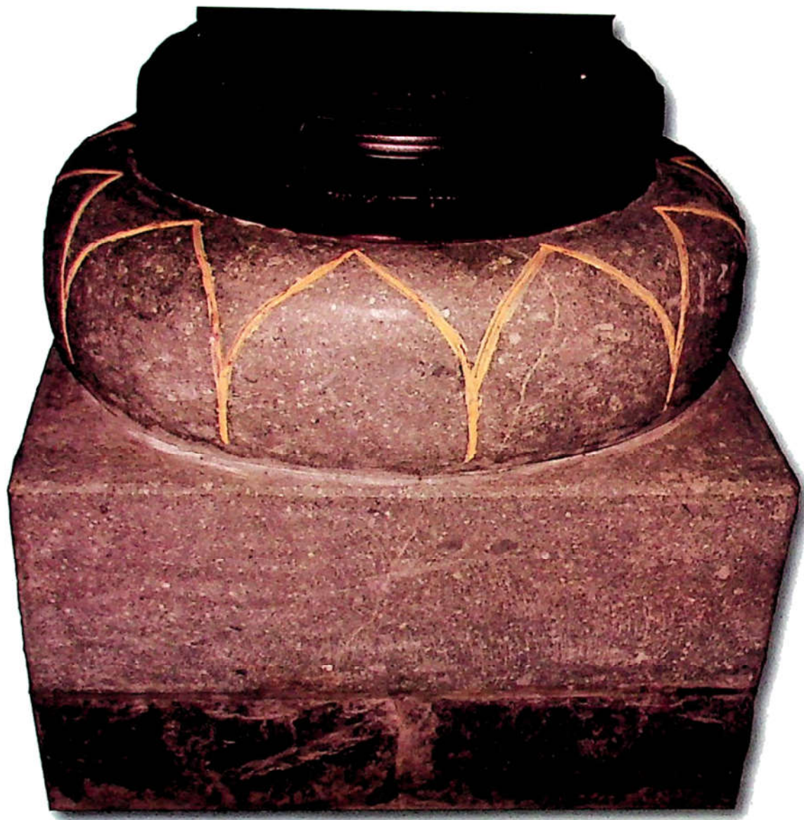
Chân cột đá nhà cổ Nguyễn Thị Thi (ấp Nhị Hòa, xã Hiệp Hòa, Tp. Biên Hòa, tỉnh Đồng Nai)
