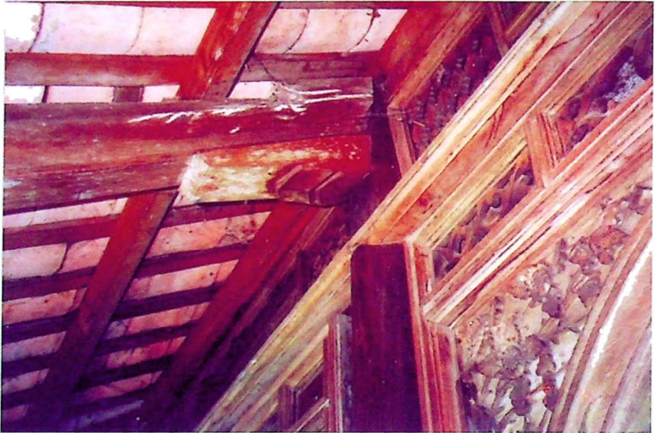
Chi tiết kèo hiên và chạm khắc khung cửa nhà cổ Trần Ngọc Khánh (xã Phước Thiện, huyện Nhơn Trạch, tỉnh Đồng Nai)
