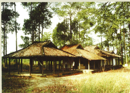
1. Nhà do (võ ca)—một trong những kiến trúc cổ được dùng làm cơ sở hành chính ở thôn xã của người Việt trước đây. Ngôi nhà do này hiện tồn tại ở Phước Thiện, huyện Nhơn Trạch. Nhà Do (vo-ca, no English equivalent), one of the ancient structural apartment designs to be used as the administrative office of the Vietnamese long ago. This nhà do is extant in the village of Phuoc Thien, Nhon Trach.
