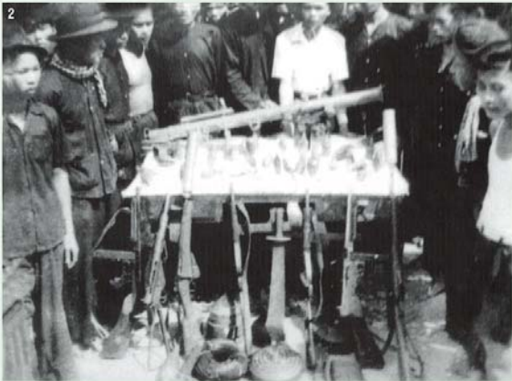
1. Công binh xưởng Chi đội 10 chế tạo vũ khí ở Chiến khu Đ thời kỳ kháng chiến chống Pháp. The arms workshop in the Strategic Base D of the Detachment 10, where weapons were made during the anti-French resistance. 2. Sản xuất địa lôi trong xưởng vũ khí ở Chiến khu Đ. Making landmines in the arms workshop in the Strategic Base D.
