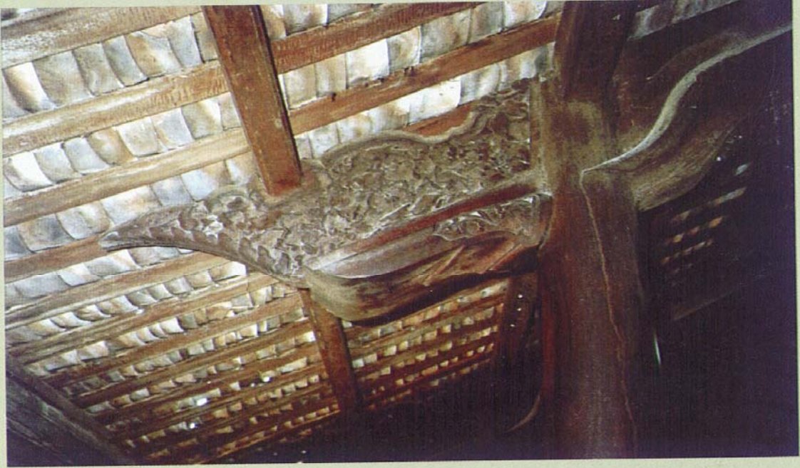
Đầu vì kèo được chạm khắc ở nhà cổ ông Nguyễn Văn Hảo.
