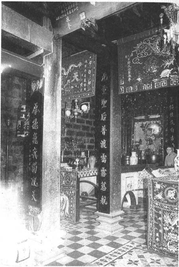
Cột, rầm, xà nhà bằng đá ở miếu Tiên tổ sư/chùa Bà Bửu Long.
