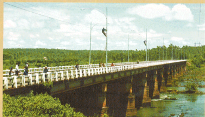
Thi công đường dây điện thấp sáng trên cầu Cứng, đường vào Chiến khu Đ.
