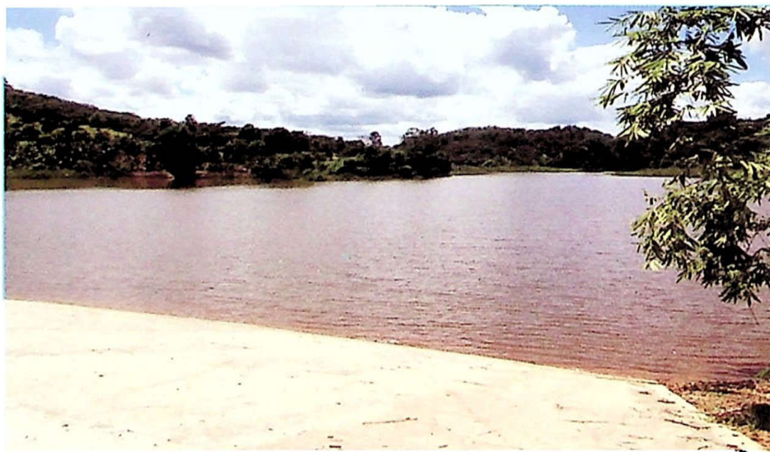
Đập Vàm Hô.
