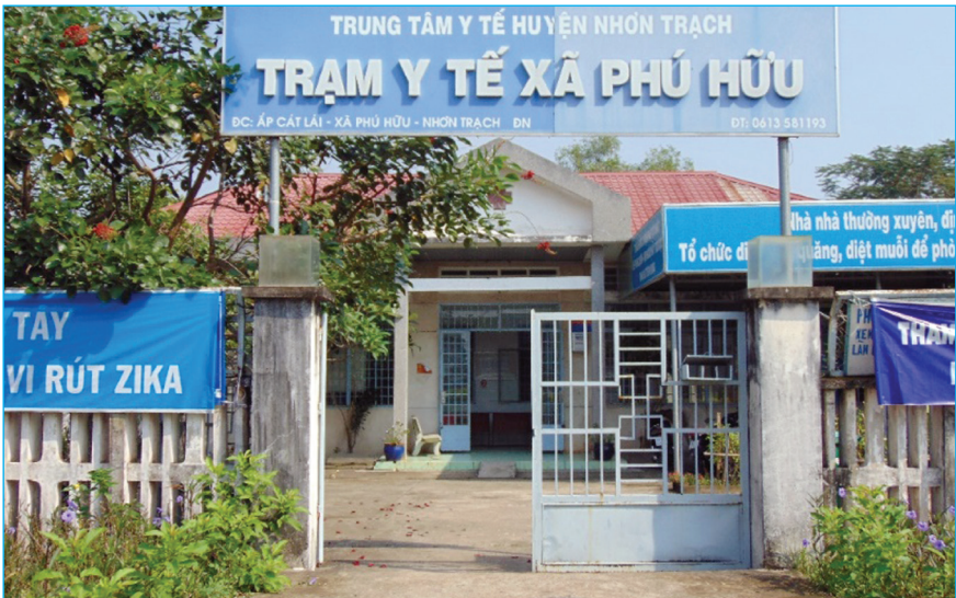
Trạm y tế xã Phú Hữu.
