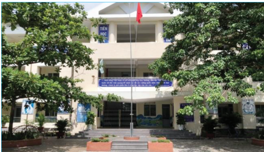
Sửa chữa trường Tiểu học Phú Thạnh, khởi công tháng 05/2020, khánh thành 06/2022.
