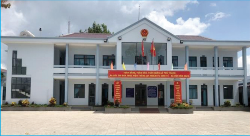
Sửa chữa trụ sở UBND xã Phú Thạnh, khởi công tháng 06/2022, khánh thành 04/2023.
