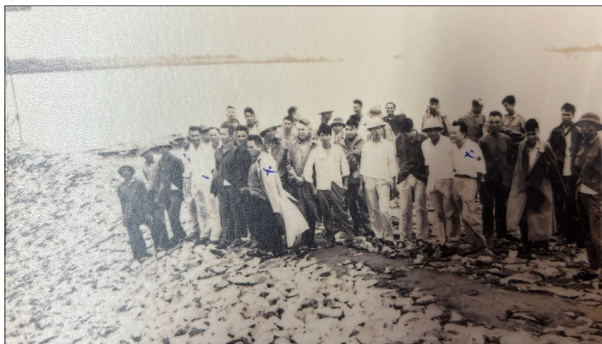
Tham gia công tác nghiệm thu kè mỏ hàn chỉnh trị sông Hồng tháng 12/1972.
