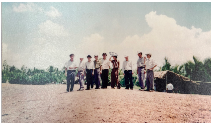
Đắp đập Suối Cả, huyện Long Thành, tháng 6/1976.
