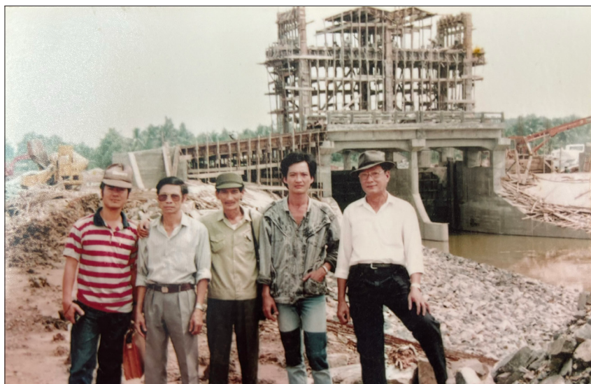
Đồng chí Huỳnh Ngọc Ẩn (thứ hai từ trái qua) kiểm tra công tác thi công cống Ông Kèo (Nhơn Trạch) năm 1991.
