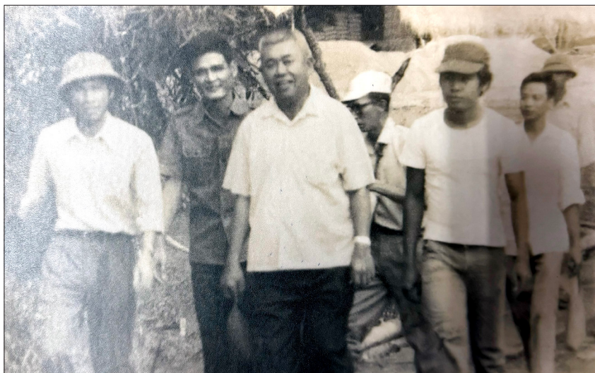
Đồng chí Huỳnh Ngọc Ẩn - Phó Giám đốc Sở Thủy lợi Đồng Nai kiểm tra thi công đập Suối Cả, huyện Long Thành, năm 1976.
