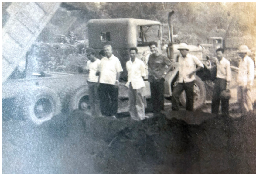
Kiểm tra công trình thủy lợi Ông Kèo, huyện Long Thành, tháng 7/1992.
