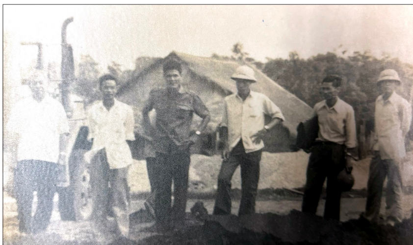
Cán bộ Sở Thủy lợi Đồng Nai kiểm tra công tác thi công đập Suối Cả, huyện Long Thành, năm 1976.
